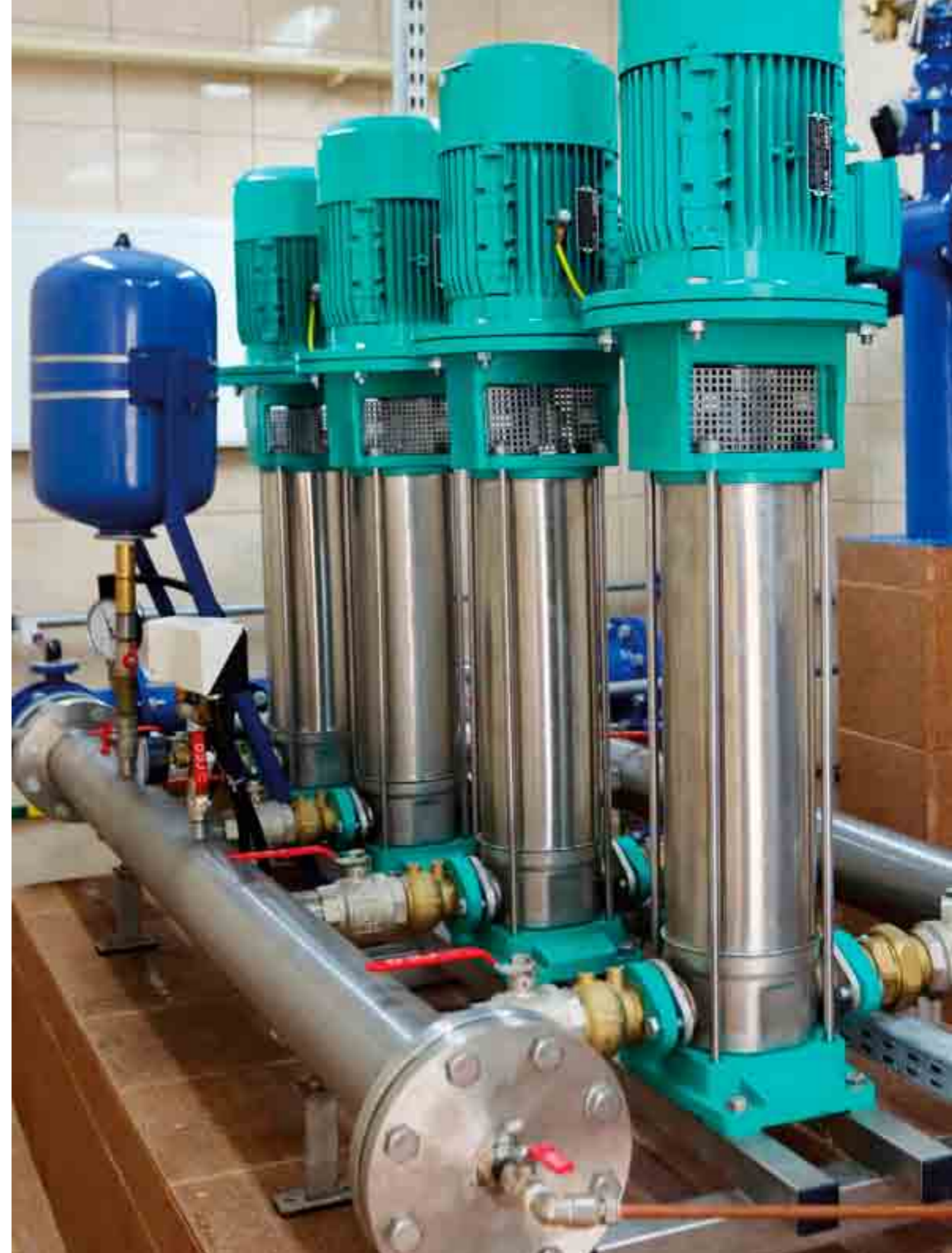
▲ Zestaw hydroforowy z osprzętem – Stacja hydroforowa „Kopiec Kościuszki”
