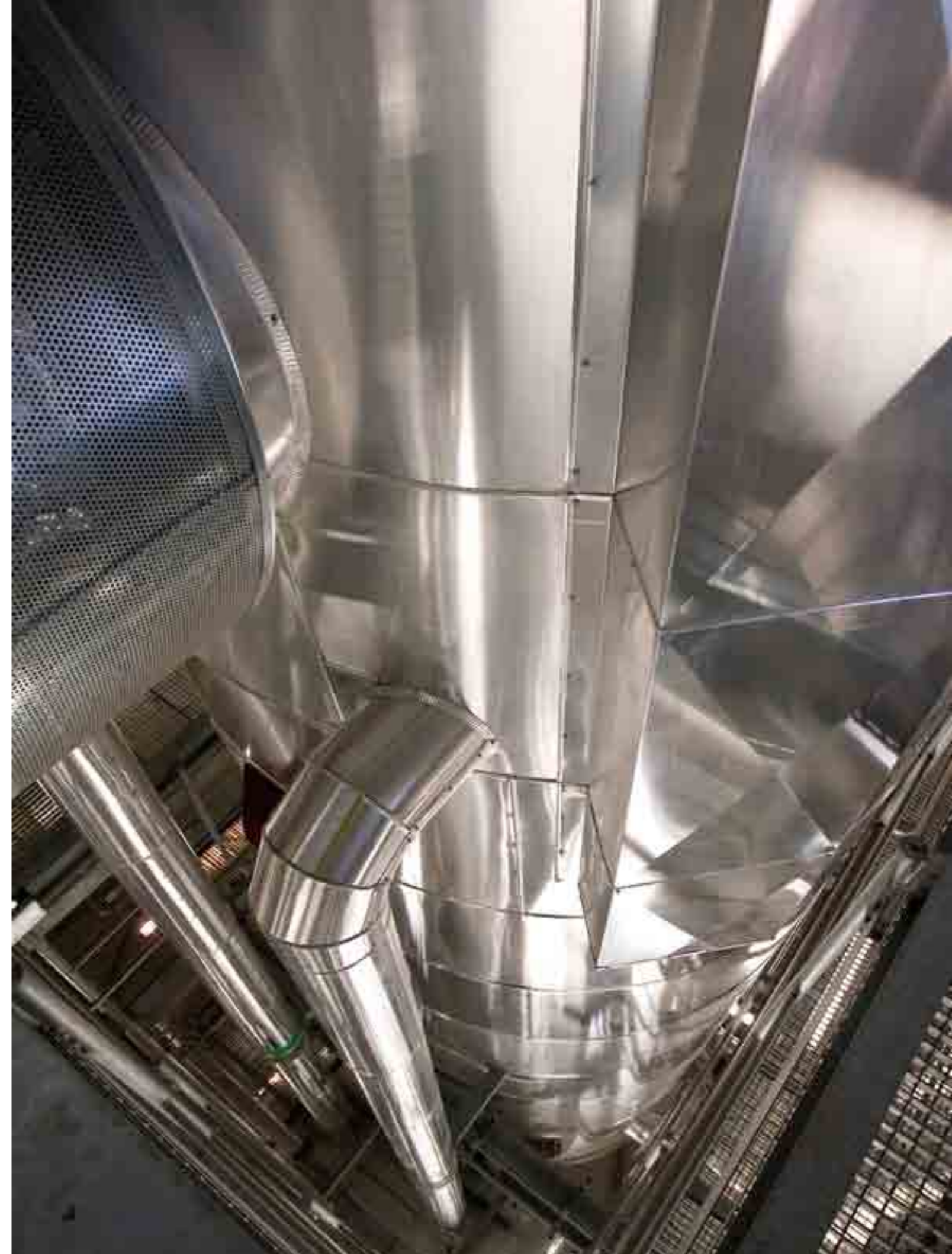
▲ Wymiennik ciepła (Ekonomizer) – Stacja Termicznej Utylizacji Osadów
